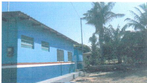
Foto 2 – Fachada Lateral Direita
