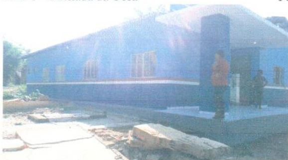
Foto 3 – Fachada lateral Esquerda
