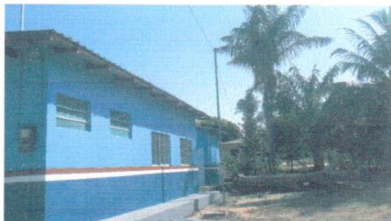
Foto 2 – Fachada Lateral Direita
