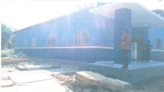
Foto 3 – Fachada lateral Esquerda
